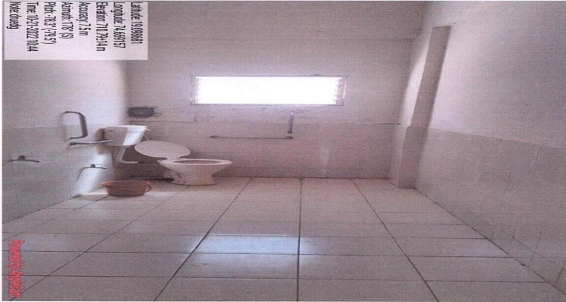
7.1.7.3 Ladies Toilet – PH (GF)
